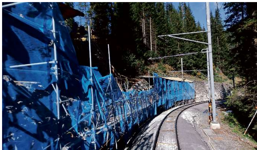
Nebst dem Bauwerk beim Leidspinagrät wird derzeit auch die Stützmauer Haspelgrube saniert.
