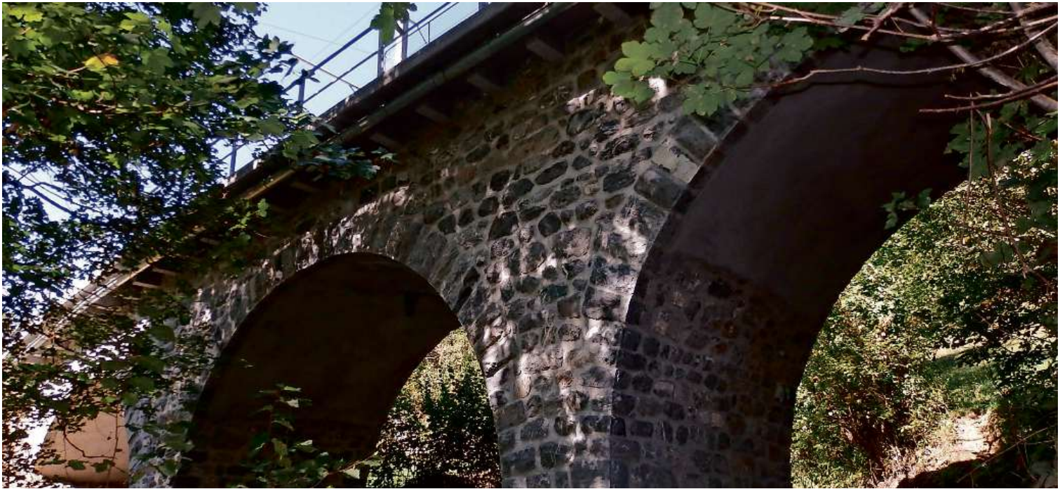
Diesen Sommer wurde das Geisseggtobelviadukt bei Peist umfassend erneuert.
