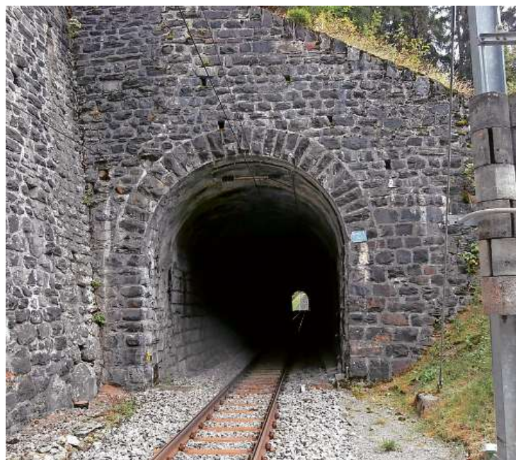
Nebst dem 114 Meter langen Mattentunnel (Bild) wurde auch der 20 Meter lange Eckentunnel bei Arosa instand gestellt.
